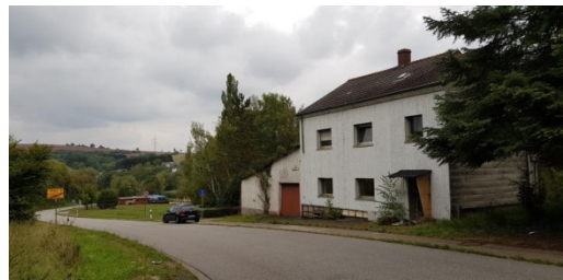
Leerstehendes Haus an Hauptdurchgangsstraße in Ortsteillage (LK Kusel)
