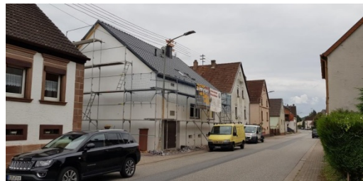
Sanierung in Ortschaft, Ohmbach, (LK Kusel)
