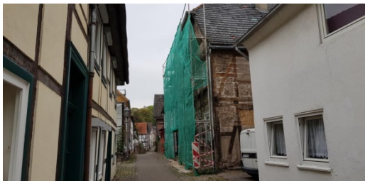
Sanierung im Bestand im Ortskern, Höxter (LK Höxter)
