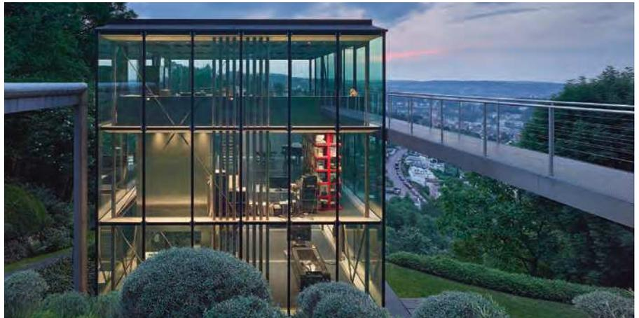
Voll recycelbar und emissionsfrei ist dieses Wohnhaus in Stuttgart (Projekt R 128). Ein gläserner Würfel, modular aufgebaut. Durch Schraub-, Steck- und Klemmverbindungen schnell und leicht errichtet und ebenso schnell demontierbar – das Baumaterial dadurch nahezu abfallfrei wieder verwendbar. Es nutzt die Sonnenenergie für Heizung und Regelungstechnik. Hier ist der Architekt und zugleich Bauherr Werner Sobek mit seiner Familie zu Hause.
