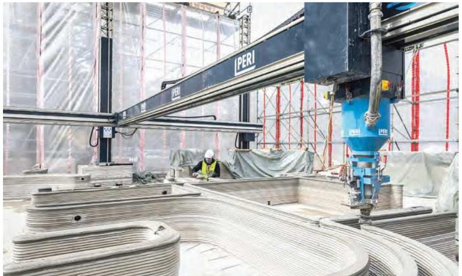
Statt Stein auf Stein, Schicht auf Schicht – In Beckum in Nordrhein-Westfalen entsteht das erste Wohnhaus aus dem 3-D-Drucker. Entworfen am Computer und von dort ohne Umwege mit dem Roboter dreidimensional „gedruckt“ samt Aussparungen für Steckdosen und Leitungen.
