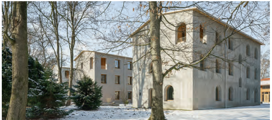
Die drei bewohnten Forschungshäuser (v.l.n.r.) Ziegel, Holz, Beton. Der verwendete Dämmbeton ist ein Infralichtbeton, wiegt 750 Kilogramm pro Kubikmeter und ist damit leichter als Wasser (Normalbeton 2,7 Tonnen pro Kubikmeter). Durch die verwendeten Zuschlagstoffe – Blähton und Blähglas statt klassisch Kies und Sand – ist er poröser und dämmt besser. Die Tragfähigkeit ist dadurch allerdings begrenzt. Hochhäuser kann man damit nicht bauen.
