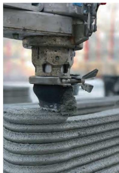
Wir wollten das Potenzial des Druckverfahrens auch für das Design aufzeigen – wie spielend leicht man damit zum Beispiel vor Ort auch Rundungen oder auch gekippte, geschwungene Stützen drucken kann. In herkömmlicher Bauweise sind solche Details nur extrem aufwendig mit einer Schalung machbar.
