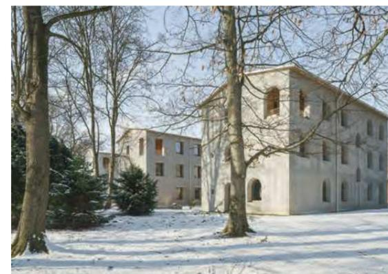
Die drei bewohnten Forschungshäuser (v.l.n.r.) Ziegel, Holz, Beton. Der verwendete Dämmbeton ist ein Infralichtbeton, wiegt 750 Kilogramm pro Kubikmeter und ist damit leichter als Wasser (Normalbeton 2,7 Tonnen pro Kubikmeter). Durch die verwendeten Zuschlagstoffe – Blähton und Blähglas statt klassisch Kies und Sand – ist er poröser und dämmt besser. Die Tragfähigkeit ist dadurch allerdings begrenzt. Hochhäuser kann man damit nicht bauen. Fotos: © Sebastian Schels
