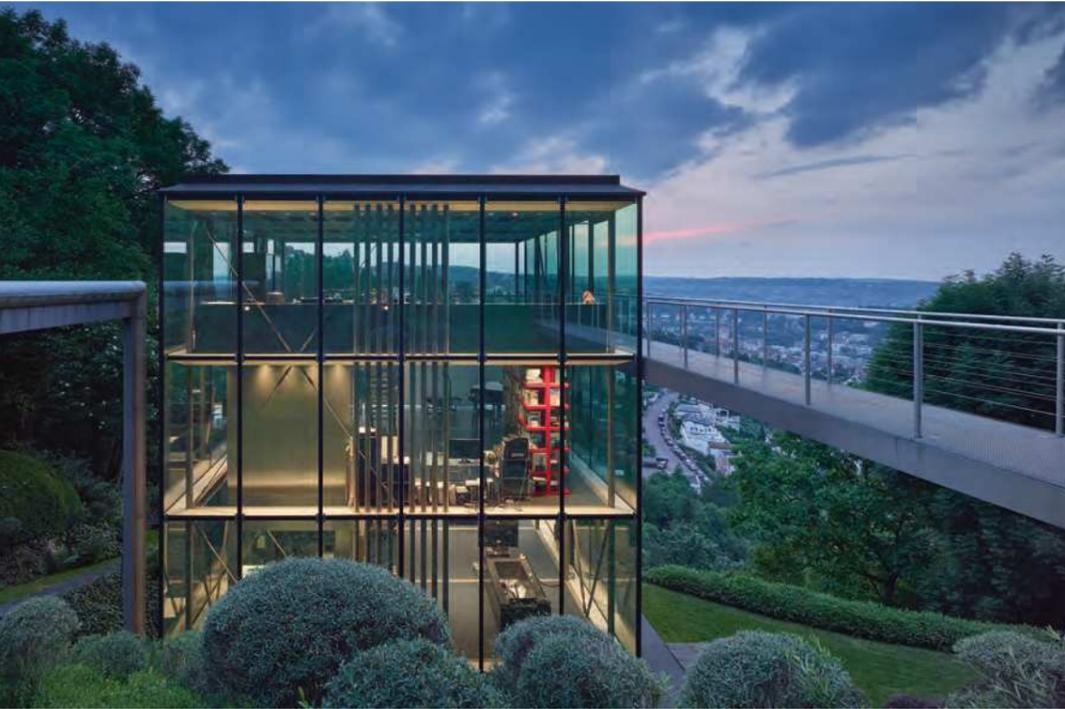
Voll recycelbar und emissionsfrei ist dieses Wohnhaus in Stuttgart (Projekt R 128). Ein gläserner Würfel, modular aufgebaut. Durch Schraub-, Steck- und Klemmverbindungen auch schnell demontierbar – das Baumaterial dadurch nahezu abfallfrei wieder verwendbar. Nutzt Sonnenergie für Heizung und Regelungstechnik. Foto: Zooney Braun, Stuttgart
