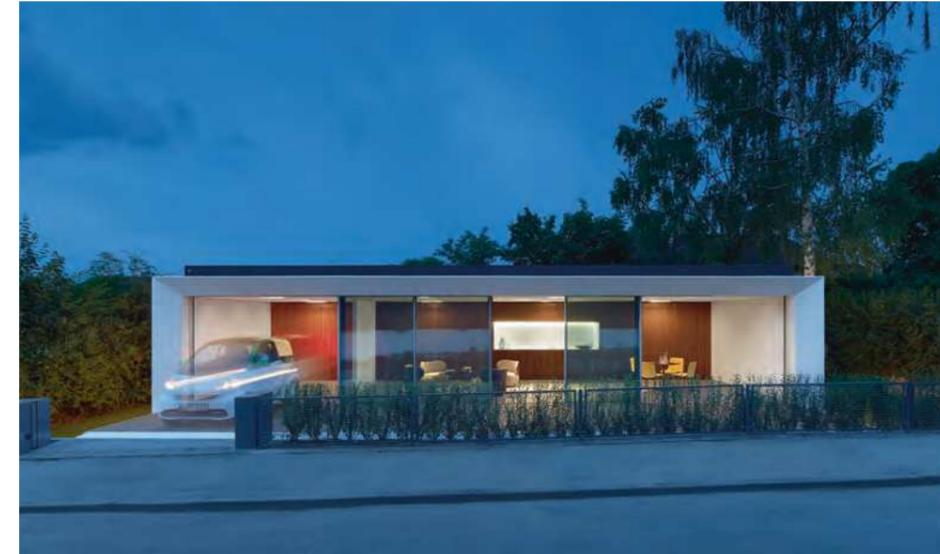
Das „Aktivhaus“ (B 10) kann deutlich mehr als das klassische Passivhaus. Erzeugt das Doppelte seines Energiebedarfs aus nachhaltigen Quellen selbst, liefert Energie auch für Elektrofahrzeuge. Der Experimentalbau war der Vorläufer für Sobeks Aktivhauskonzept, mit dem nachhaltiges serielles modulares Bauen in kürzester Zeit möglich ist. Die Modulgrößen des Aktivhauses reichen vom sehr kleinen Modul mit einer Nettowohnfläche von 28,5 bis 186 Quadratmeter. Foto: Zooney Braun, Stuttgart
