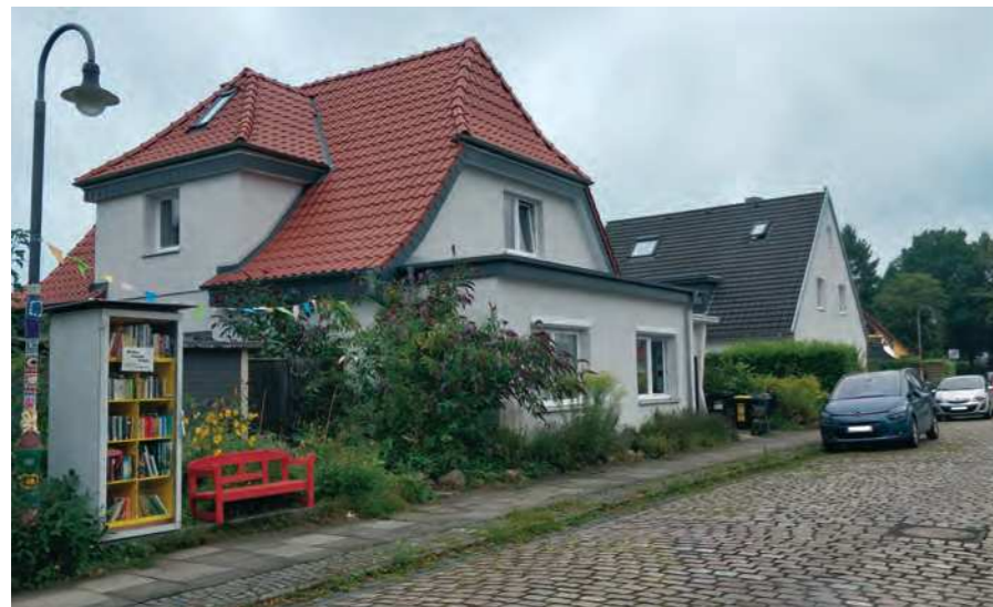
Das genossenschaftliche Wohnprojekt Stadtweltraum in Bremen-Habenhausen entstand in rekordverdächtiger Zeit: zwei Monate Vorbereitung plus drei Monate Umsetzung. Heute präsentieren sich die beiden vormaligen Einfamilienhäuser, Baujahr 1893, voll energetisch saniert. Zur Pelletheizung kamen 2024 zwei PV-Anlagen hinzu. Fotos: Petra Schultz-Adebahr
